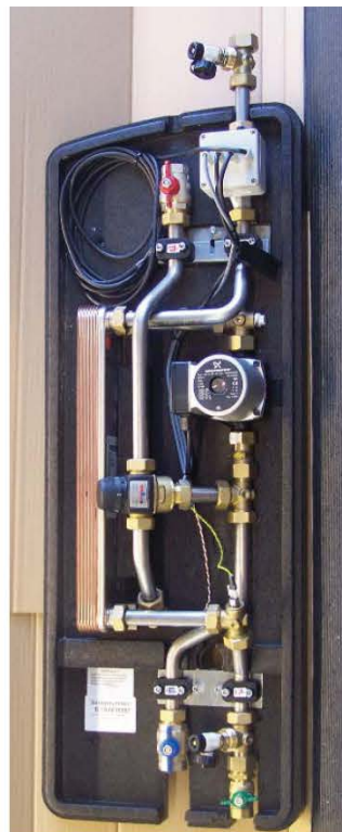
Station mit Mischeinheit mit Spülmöglichkeit
