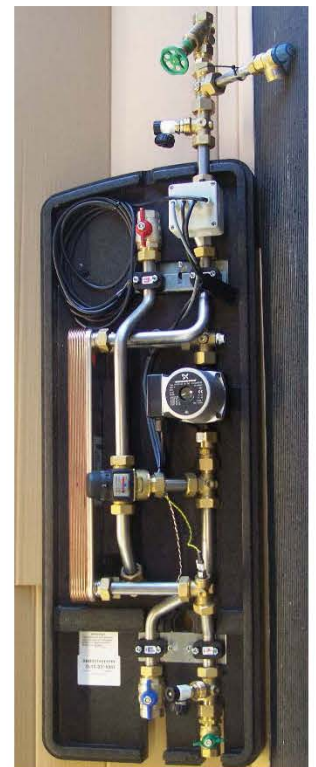
Station mit Mischeinheit mit Spülmöglichkeit mit Sicherheitsgruppe
